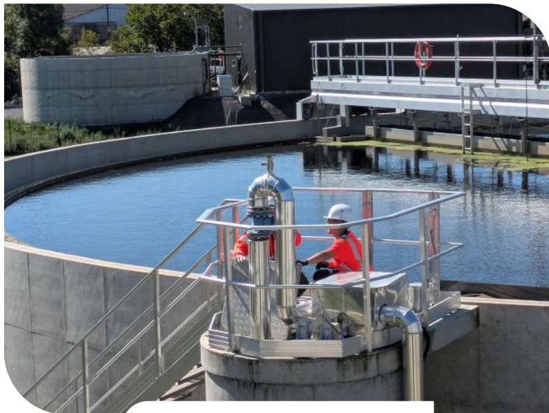
Station d'épuration de Feurs
